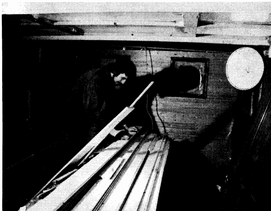
Isolasjonen er limt på skottene, garneringen legges opp.
