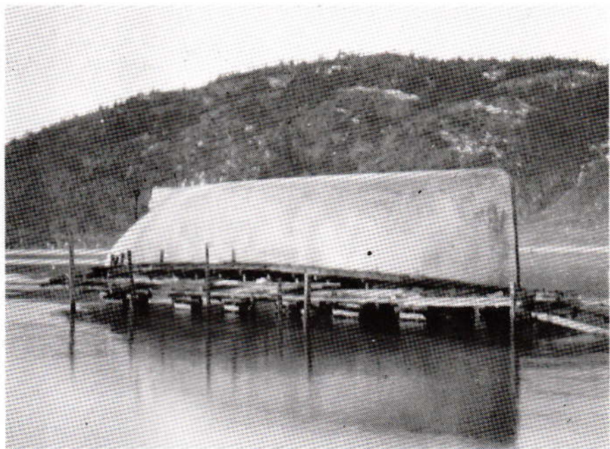
Betongskrog under bygging ved Porsgrund Cementstøperi
