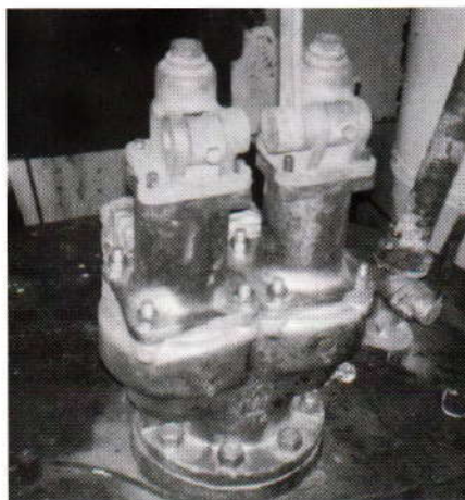
Sikkerhetsventiler etter reparasjon, des. 1991
