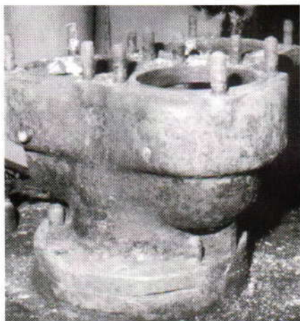
Sikkerhetsventiler før reparasjon, juni 1991
