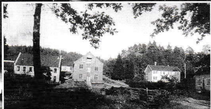
Sjølingstad Uldvarefabrik, Våningen og Butikken.
