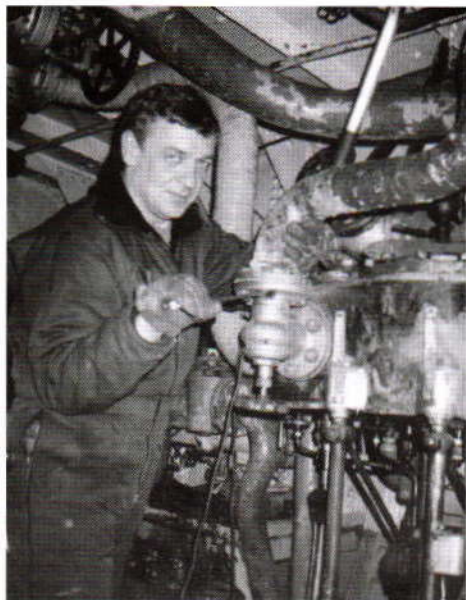
Terje Bjerén. Montering av ventil til sirkulasjonspumpen
