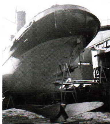
Skutebunn – «Styrbjørn», plater fjernet, maskinsjef Lindnes på inspeksjon.
