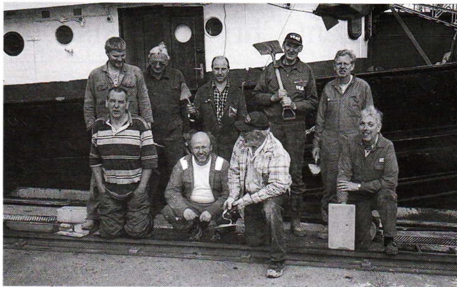
Juni 2000. En fornøyd gjeng etter å ha støpt 4,5 tonn betong i skutebunn.
