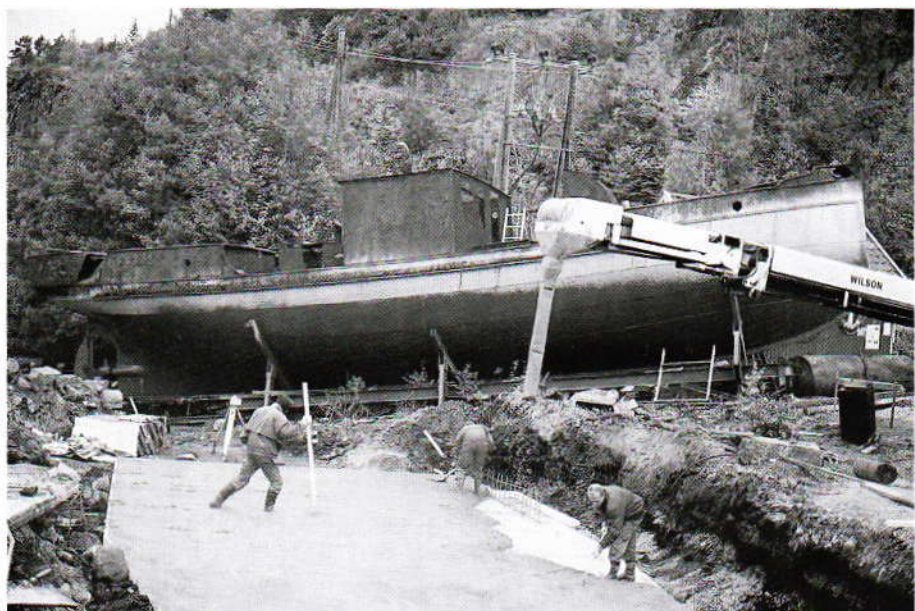
"Stadshauptmand Schwartz" – et kulturminne på land. Bygging av fundament for varig plassering ble utført i 2000. Foto: Thor Hansen
