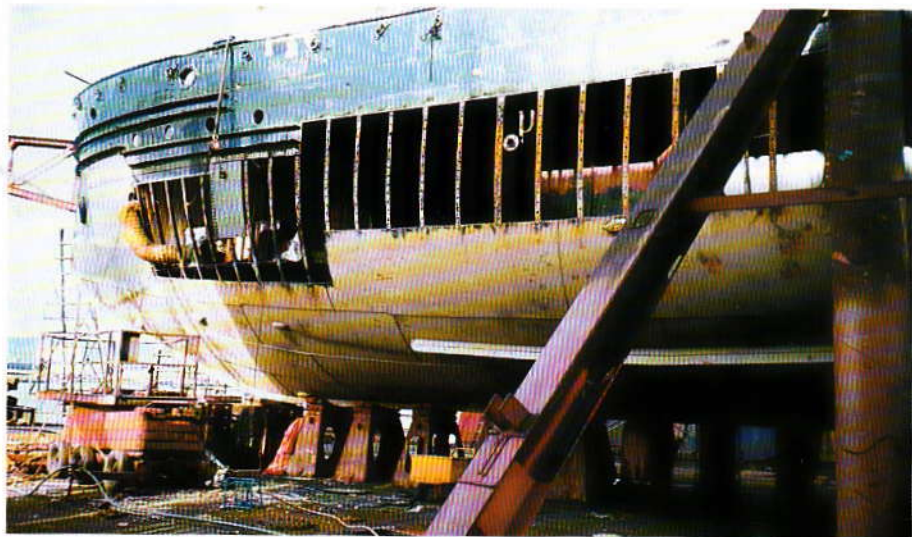
Mye klinking for å holde nye plater på plass.
