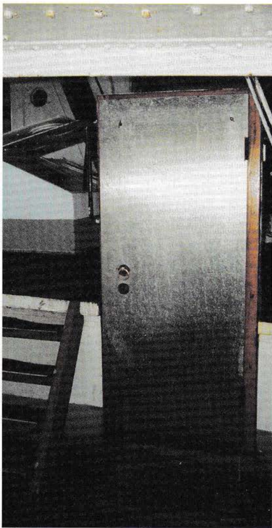
Aluminiumsplate montert på dørens utside.
