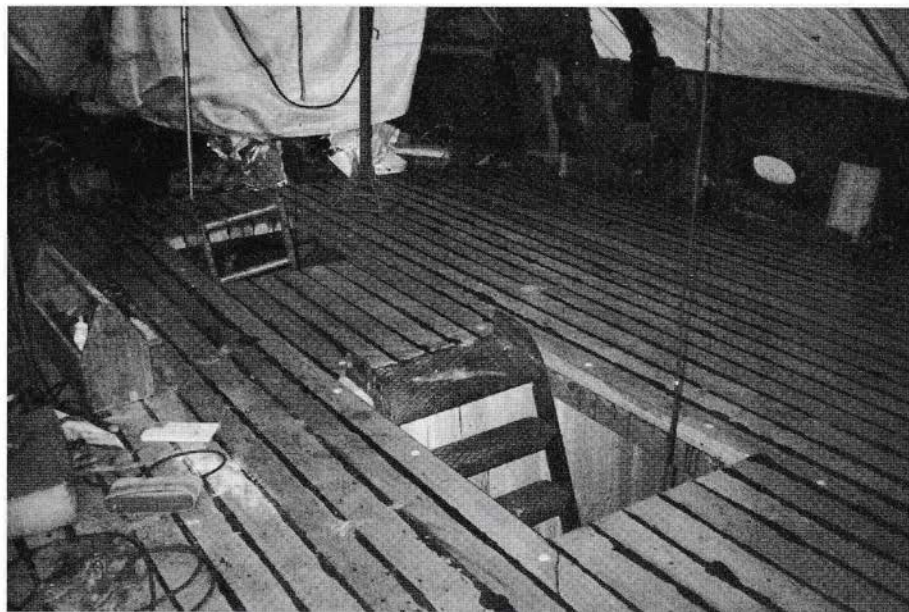
Nytt dekk ferdig i januar 2003.
