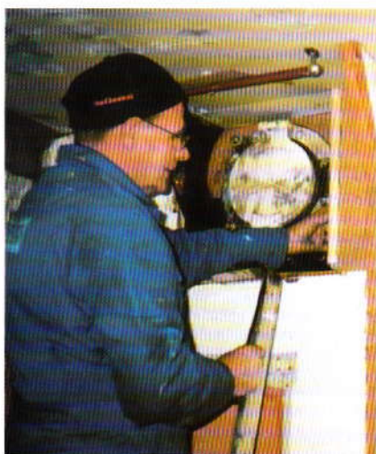
Olav Indsetviken, "tusenkunstner", remontering av maskinistlugar.
