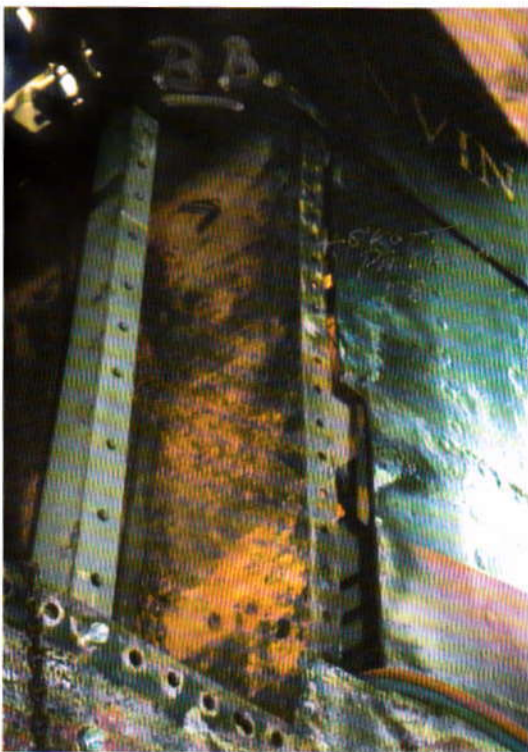
Gjenoppbygning av bauen på "Granvin" viser klinking av nye stålplater og spant.
