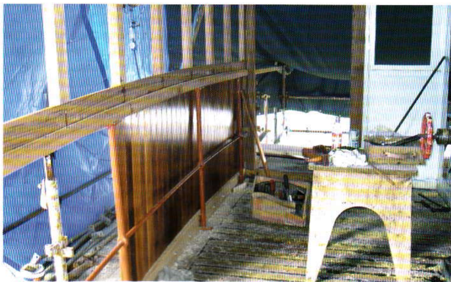
Hardanger Fartøyvernssenter er i ferd med å sette opp styrehuset. April 2005. Foto: Harald Sætre
