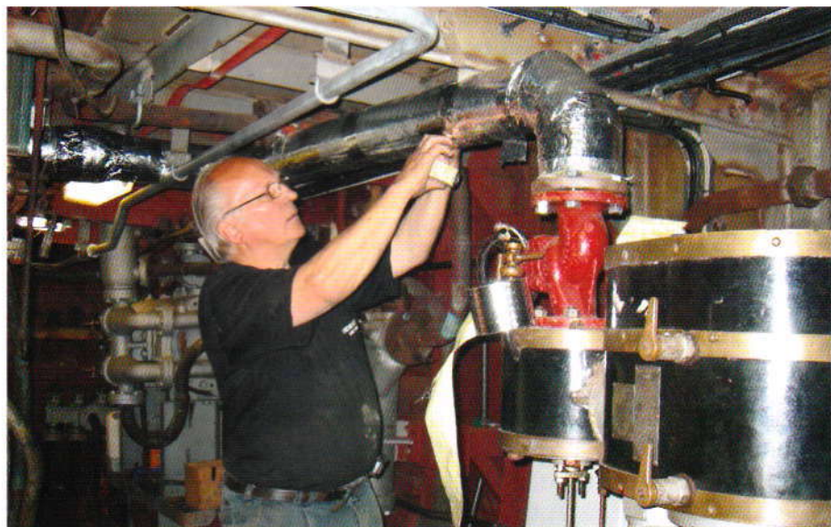
Det var mange meter dampprør som skulle isoleres og for dugnadsgjengen ble det mange sene sommerkvelder om bord. Her er Arne Sundal i ferd med å slutføre isoleringen av de mange dampprørene.
