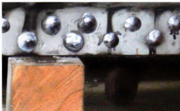
Sveising er tabu på en verneverdig båt. Her er det bare klinking som tillates.
