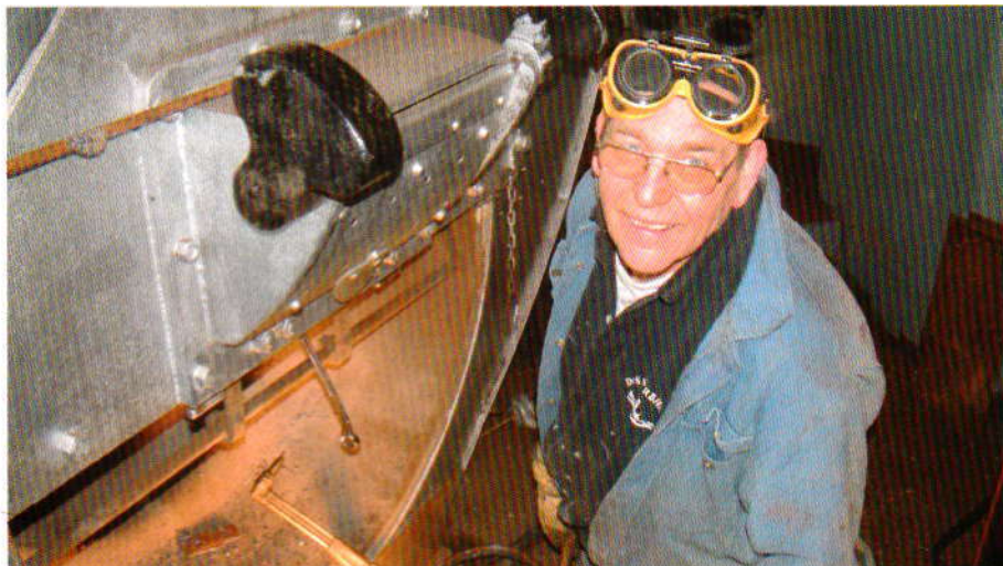
Tom Gundersen utfører reparasjon av fyrdøren.
