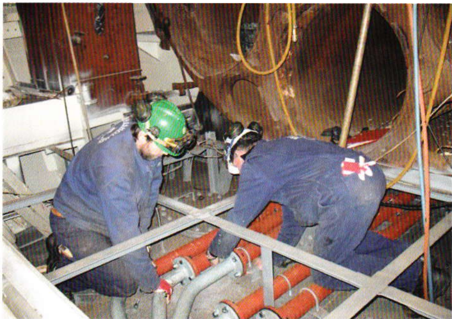
Rørlegging under maskindøren.
