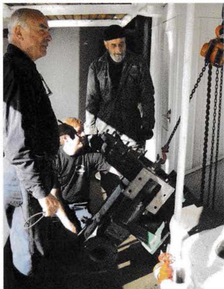
Ferdig maskinert pumpehus på vei ned gjennom skyligthen. Fra venstre maskinsjef Arnold Lindner, matros Roy Uhen maskinist Kaspar Lien.
