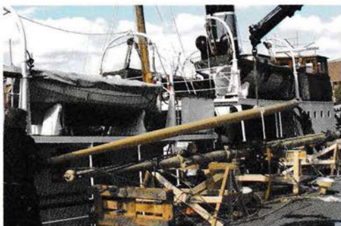
Den nye masten, legges pent ned ved siden av den gamle, og så kan arbeidet med å fjerne alle stagfester, ledninger og beslag begynne.
