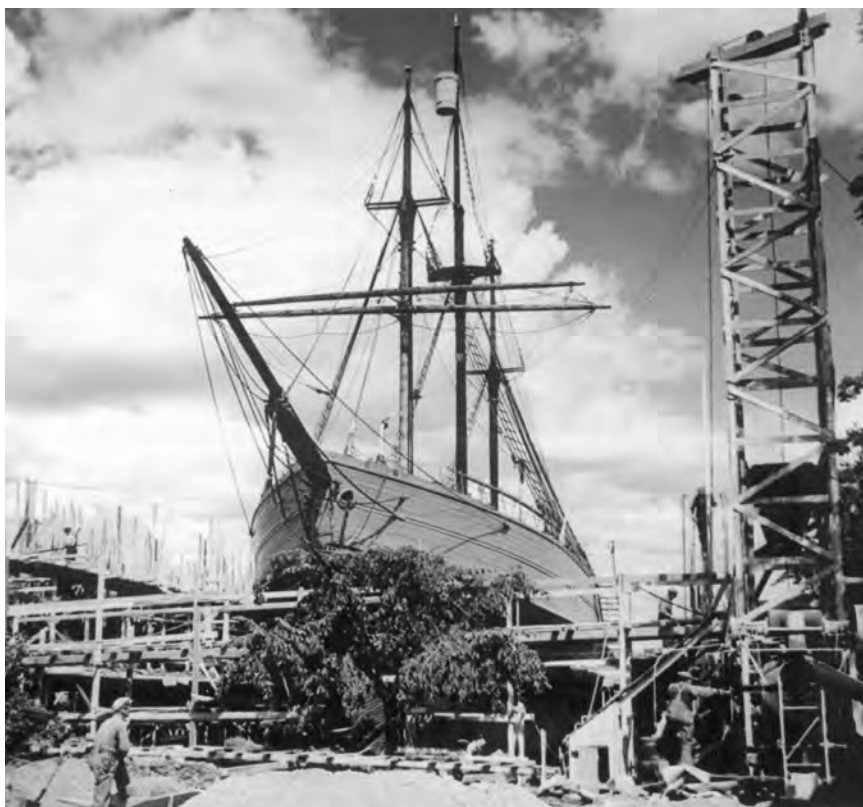
Her er Fram på plass på land i 1936 i sementkrybben sin, og huset skal bygges rundt
