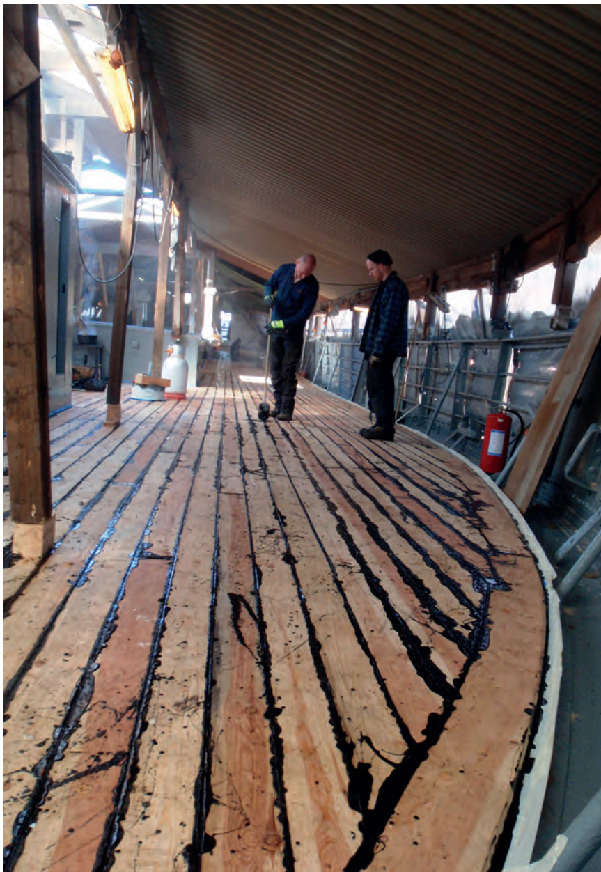
Det er nå lagt tredekk over Hestmandens lasterom. Arbeidet ble utført av Hardanger fartøyvernsenter, som avsluttet med å beke natene i april i år. Foto: Bredalsholmen v/Svein Vik Såghus
