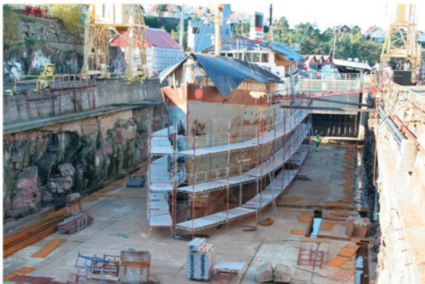
«Kysten I» får de avsluttende arbeider i dokka på Bredalsholmen før sleping til Tønsberg. Foto: Bredalsholmen
