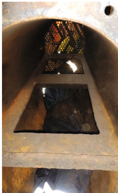
Slik er det ikke mange som har sett kondenseren. Her rengjøres den innvendig.
