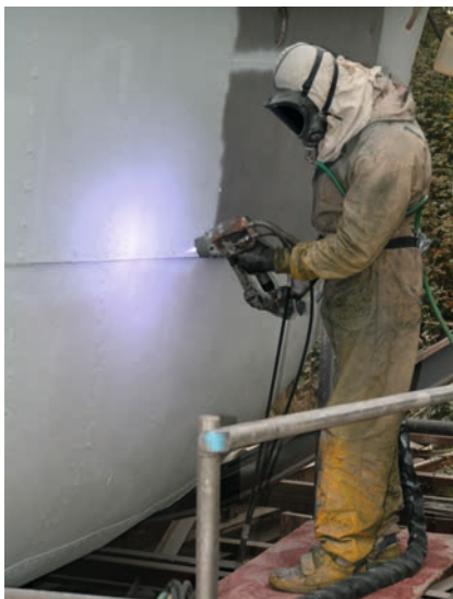
Lysbuesprøyting av zink. Dette er en jobb for fagfolk.
