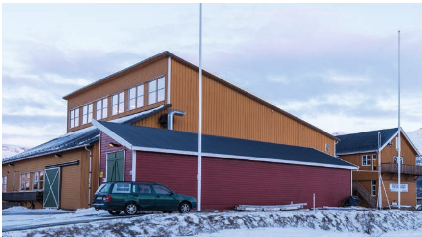
Slipphallen. I forgrunn ser vi materiallager med vinsjebu. Til høyre er bygget med delelageret i underetasjen. Ytterst til høyre skimter vi det nye materiallageret.
