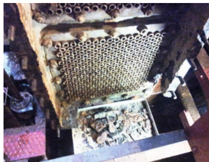
Fremre rørplate. Det nye mellomstykket (vendekammervegg) festes i de samme boltene som rørplatene er festet i.
