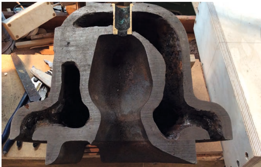
Bildet viser den kløyvde toppen. Til høyre ved underkant av messinghylsa ser en partiet med sterkt redusert godstykkelse. Et par cm bak snittflaten et gjenværende godstykkelser kun 3–4 mm.
