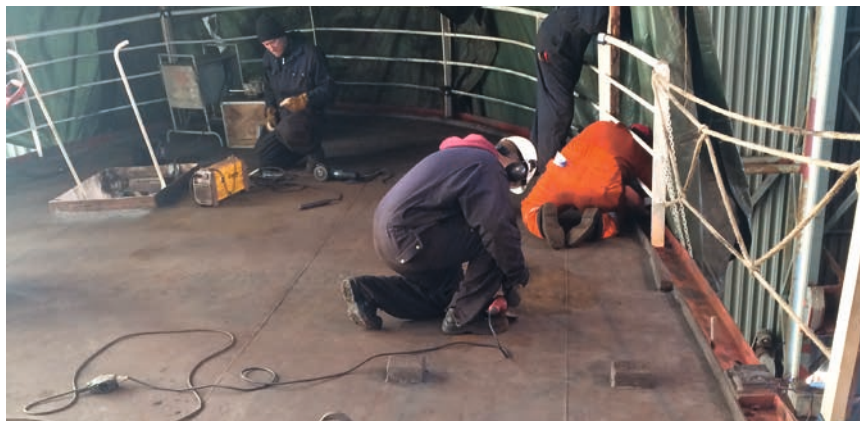
Fra båtdekket, her skal det legges tredekk oppå stålet.
