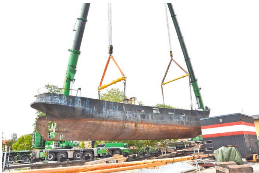
Skroget løftes af slippvognen og inn på land. Foto: Tom Rasmussen.
