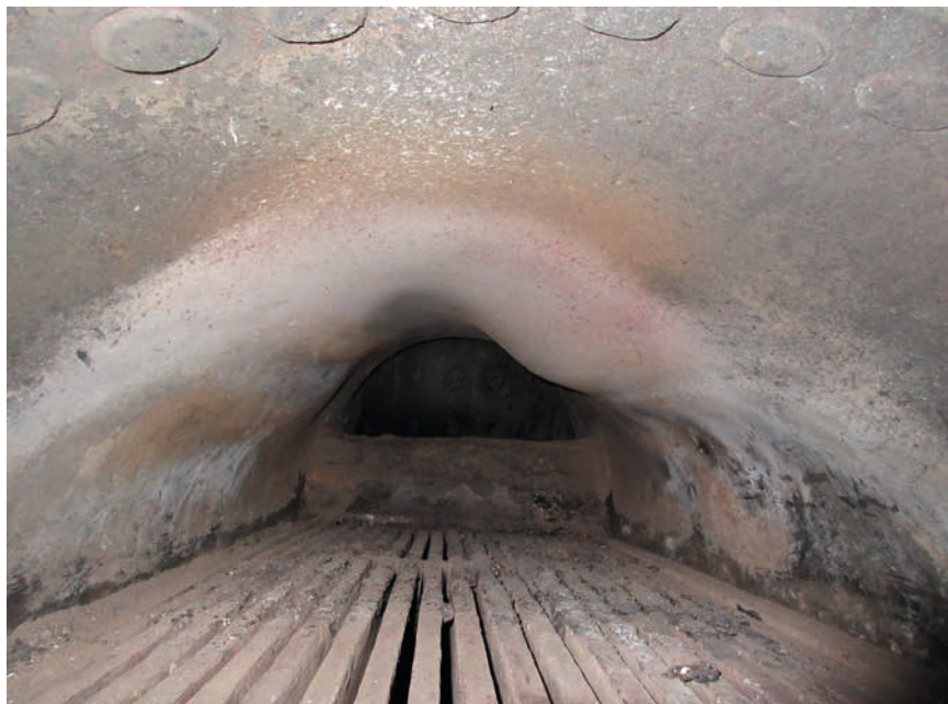
Slik ser den ut, fyrgangen som skal være sirkulær.
