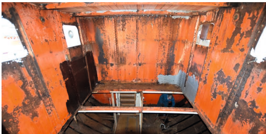
MS Granvin - demontert røykesalong. I samband med dokumentasjons- og reparasjonsarbeidet er all innreiing om bord teke ut. Foto: Hardanger fartøyvernssenter.
