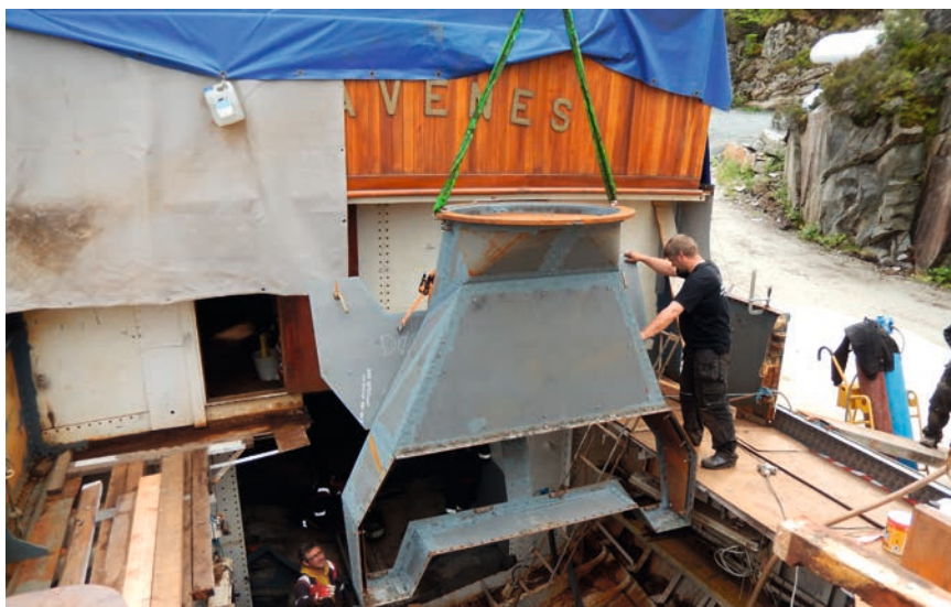
Røykopptaket på vei ned gjennom fordekket. Vel nede skal det skyves akterover mot fyrdørken. Etterpå kommer kjelen samme vei, og forbindes med røykopptaket.
