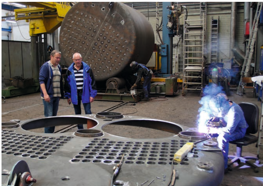
Fronten på den nye kjelen under arbeid. Vi ser tydelig kragene rundt mann hullene som ga problemer da kjelen ble heist på plass.
