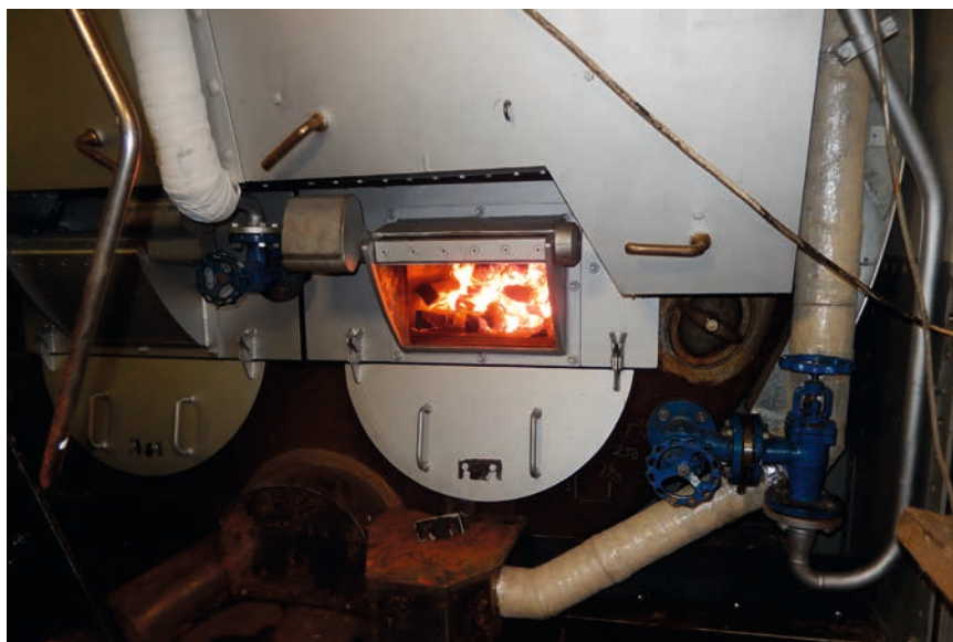
Alt er montert, kjelen er fylt med destillert vann, og en forsiktig prøvefyring er startet.
