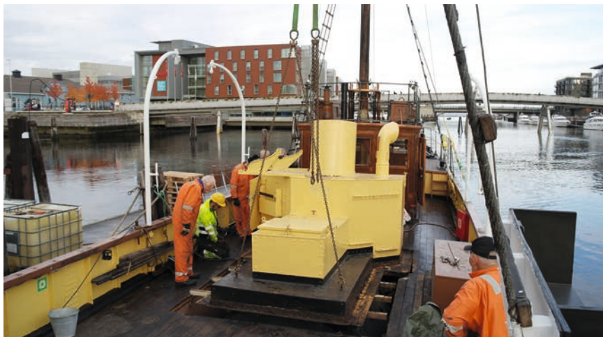
Dekksplanker er fjernet og skorstein tatt av. Maskincasing er i ferd med å bli løsnert.
