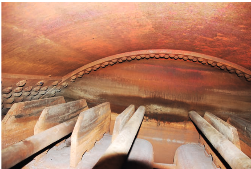
Så rent er det i kjelen på «Oster». Vi ser tre stagbolter og ribbene som forsterker taket i ildkassene.
