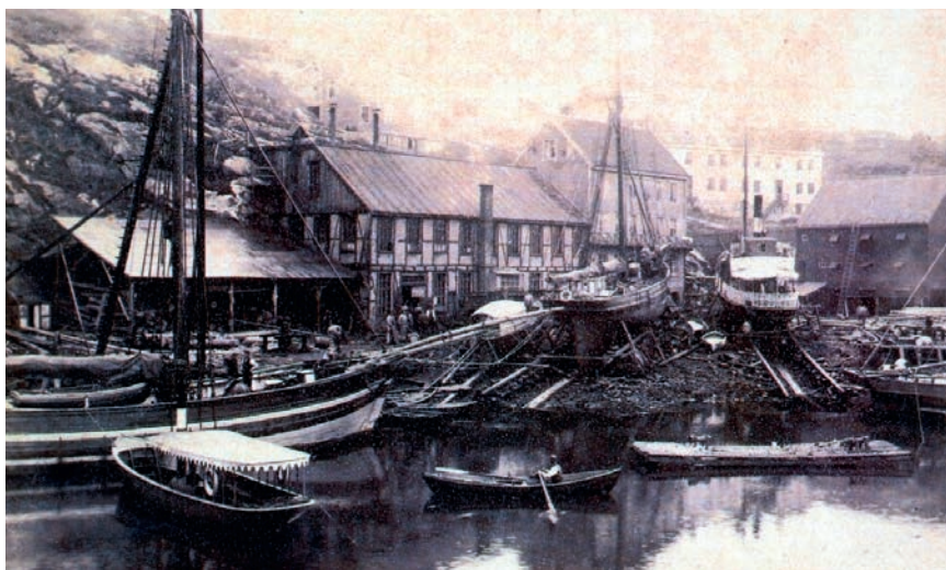
Slik så Mellemværftet ut i tiden omkring forrige århundreskifte. Omtrent slik ser det ut i dag også. Mastekrana til venstre i bildet er imidlertid borte.
