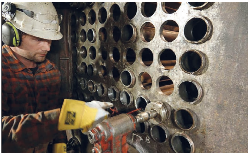
Arbeidet er snart fullført, her vales nye røykrør inn.
