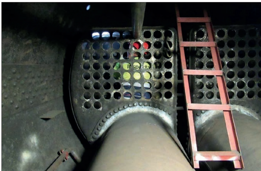
Kontrolløren i arbeid inne i babord ildkasse. Kjelen virker romslig når alle røyk- og stagrør er fjernet. Nede til venstre ser vi røret for bunnblåsing.
