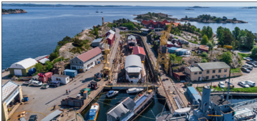
Slik ser det ut på Bredalsholmen. Både kaier og tørrdokk er fylt opp med fartøyer. Foto: Sønnavind dronefoto
