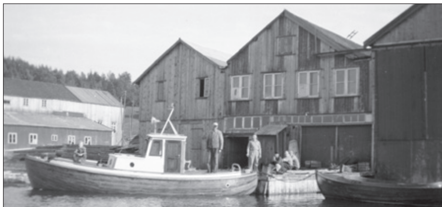
Em. Moen & Sønns båtbyggeri sett fra sjøsiden, ca 1960. Til venstre Thor N. Sauviks båtbyggeri med den lange, lyse bygningen der minesveiperen KNM «Tista» ble bygget. Foto fra Emanuel Moens fotosamling, utlånt av Asbjørn Halvorsen.
