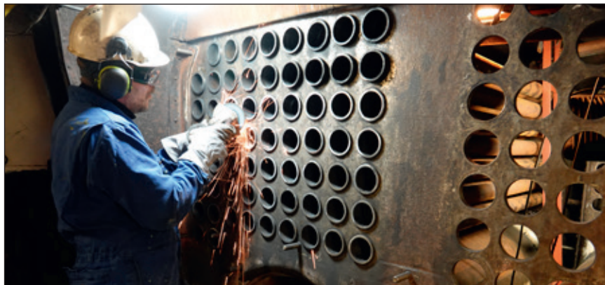
Tilpasning av nye røykrør på «Børøysund», eksempel på håndverksferdigheter som finnes på verkstedet. Foto: Bredalsholmen
