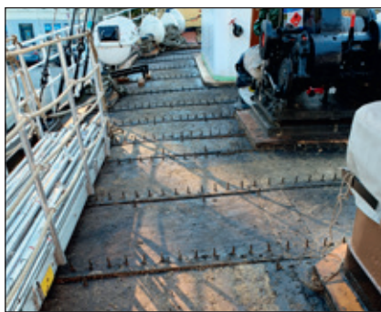
Dekket på «Stord I». Her skal det gjøres arbeider i løpet av vinteren. Foto: Harald Sætre
