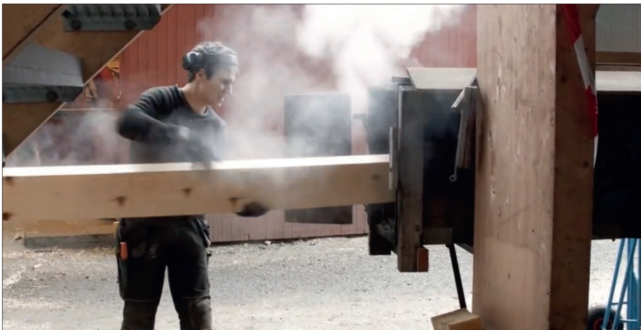
Hudplank til «Fremad II» trekkes ut av steamkassen ved slippen. Her blir bordene varmet med damp til de blir myke nok til å bøyes etter skrogets krumming. Erfaringen tilsier en times varming for hver tomme tykkelse. Slikt restaureringsarbeid dokumenteres og formidles underveis i sosiale medier. Stillbilde fra video.
