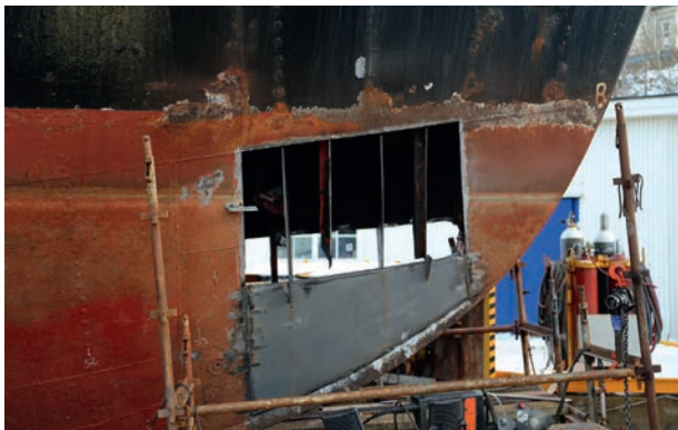
Her blir stålplater i baugen skiftet ut. Foto: Trond Carlsen
