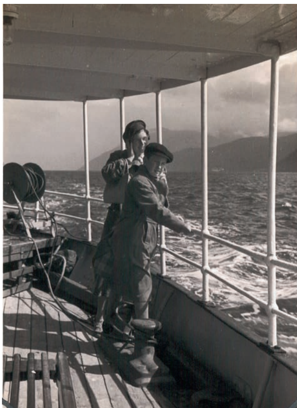
Slik så rekka og støttene for promenadedekket ut. Nok et eksempel på hvor viktig fotografiet er som kildemateriale. Foto via Øyvind Konglevoll.
