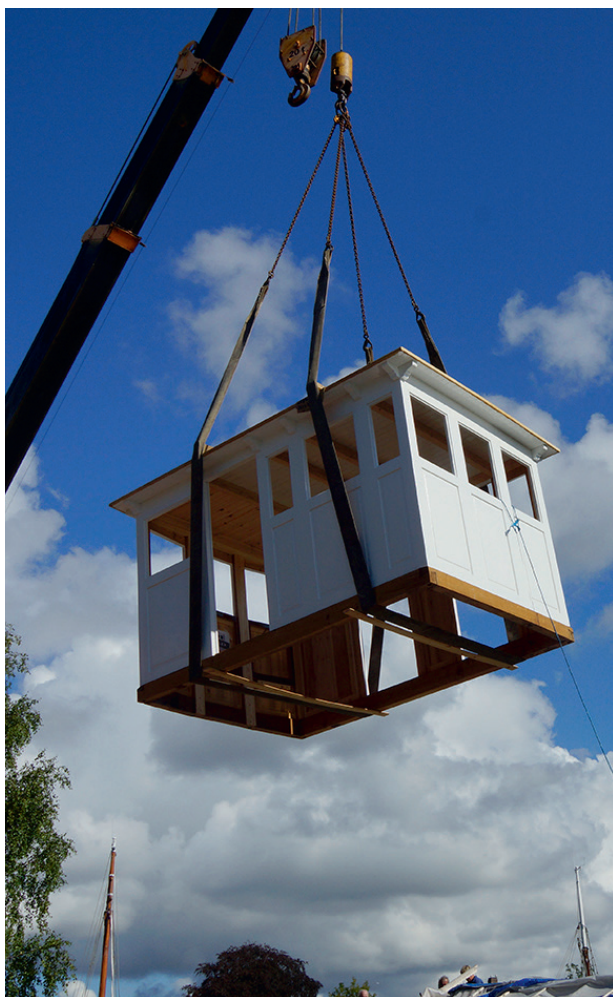
Styrhuset kommer luftveien.
