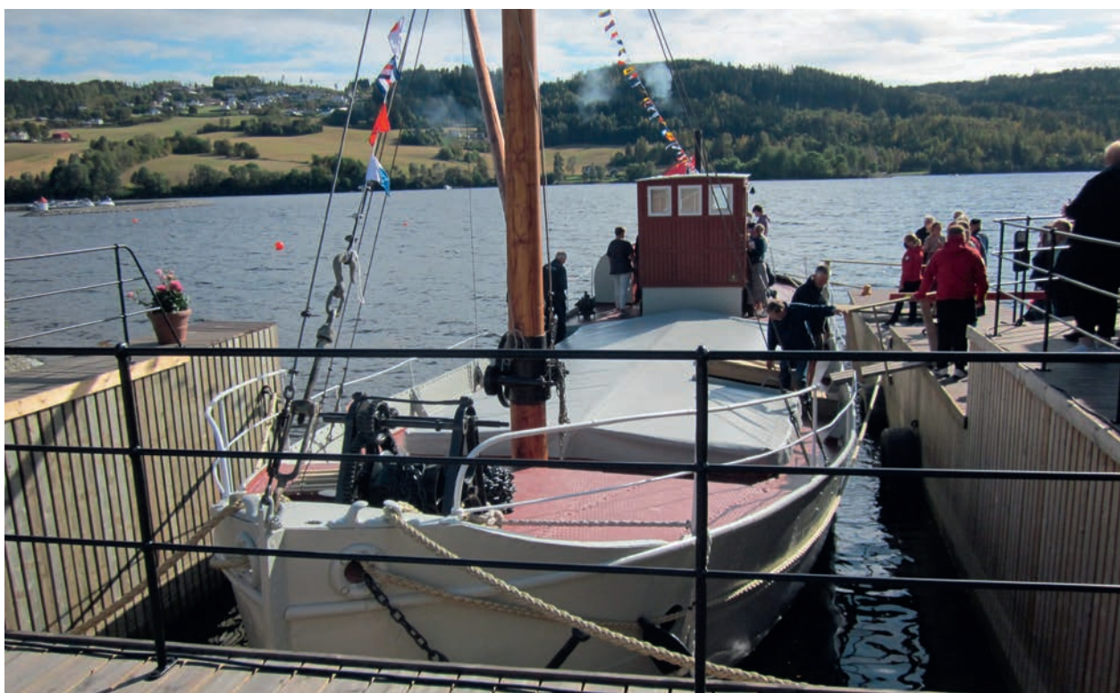
«Brandbu» fortøyd i det nye kaianlegget. Foto: Georg Jensen.
