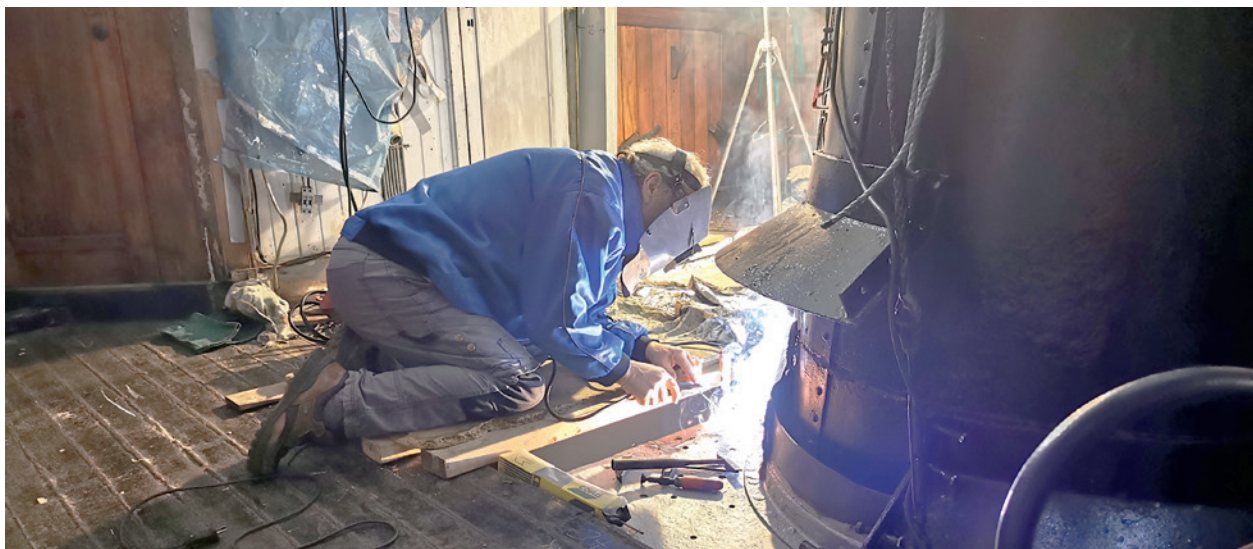
Sveising i dekket under akterkant av bestikklugaren. Den vil strekke seg frem til den hvitmaltte veggen bak sveiseren. Foto: Jan Ragnar Setsaas
