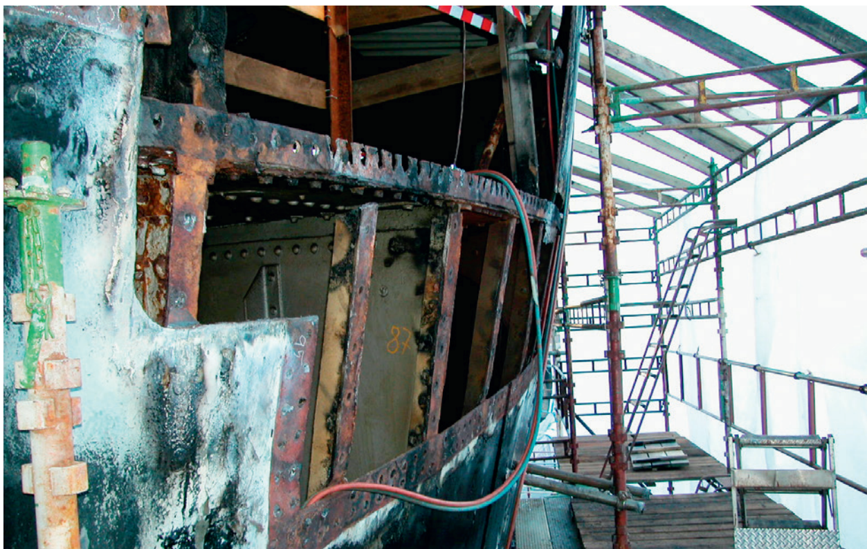
Slik så det ut på «Hestmanden» tidlig i restaureringen. Har vi i dag mot og ressurser til å gå løs på et slikt prosjekt? Foto: Bredalsholmen Dokk og Fartøyvernssenter
