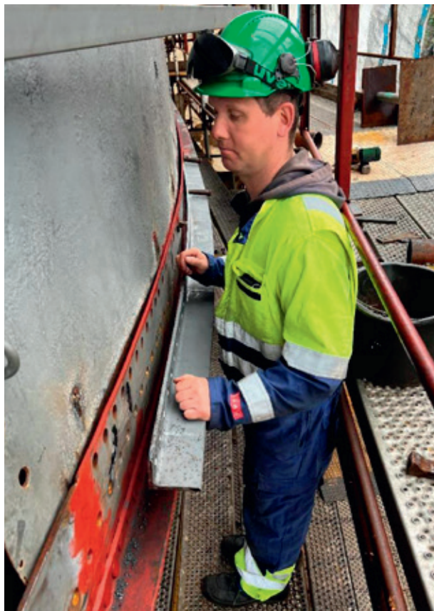
Den nye spanteovnen kommer til nytte når fenderlistene skal bøyes. Foto via Morten Hesthammer.
