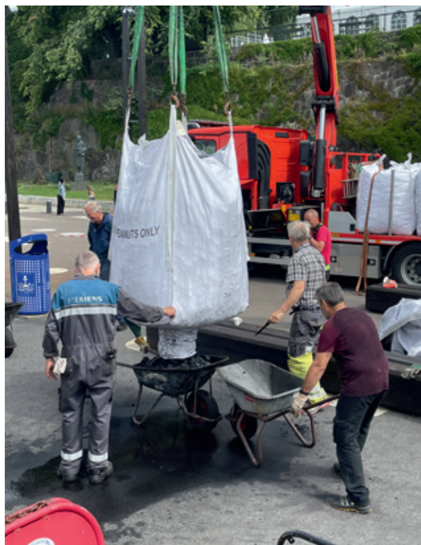
Skuta trenger kull, mer enn 200 kilo i timen. Her bunkres, først i Oslo så på Husøy. Legg merke til teknikken med to trillebører som pendler under sekken.
